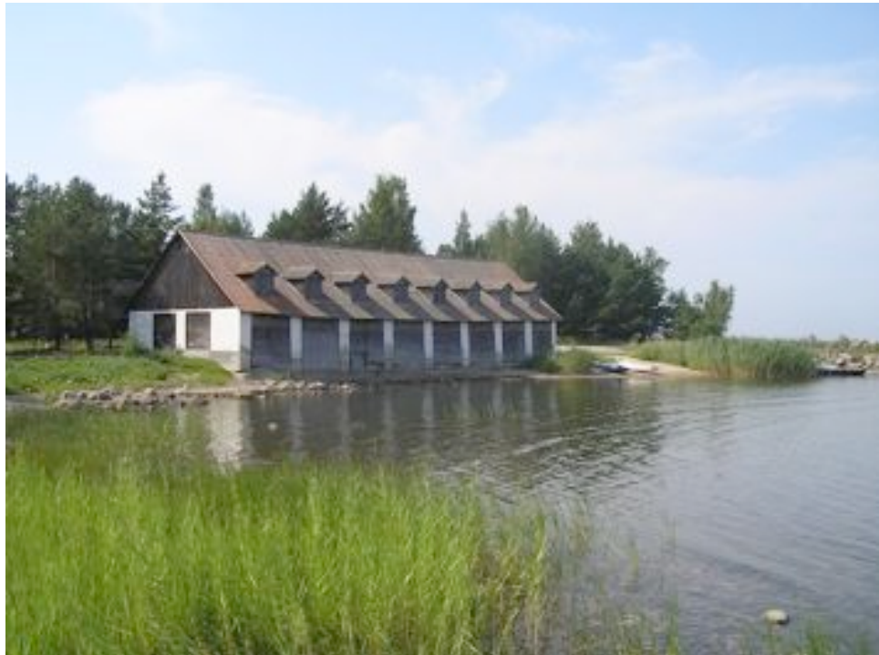
Foto 3: Vaade sadama senisele peahoonele mere poolt. Hoone vundament on tugevate kahjustustega. Foto on tehtud enne augustitormi.
