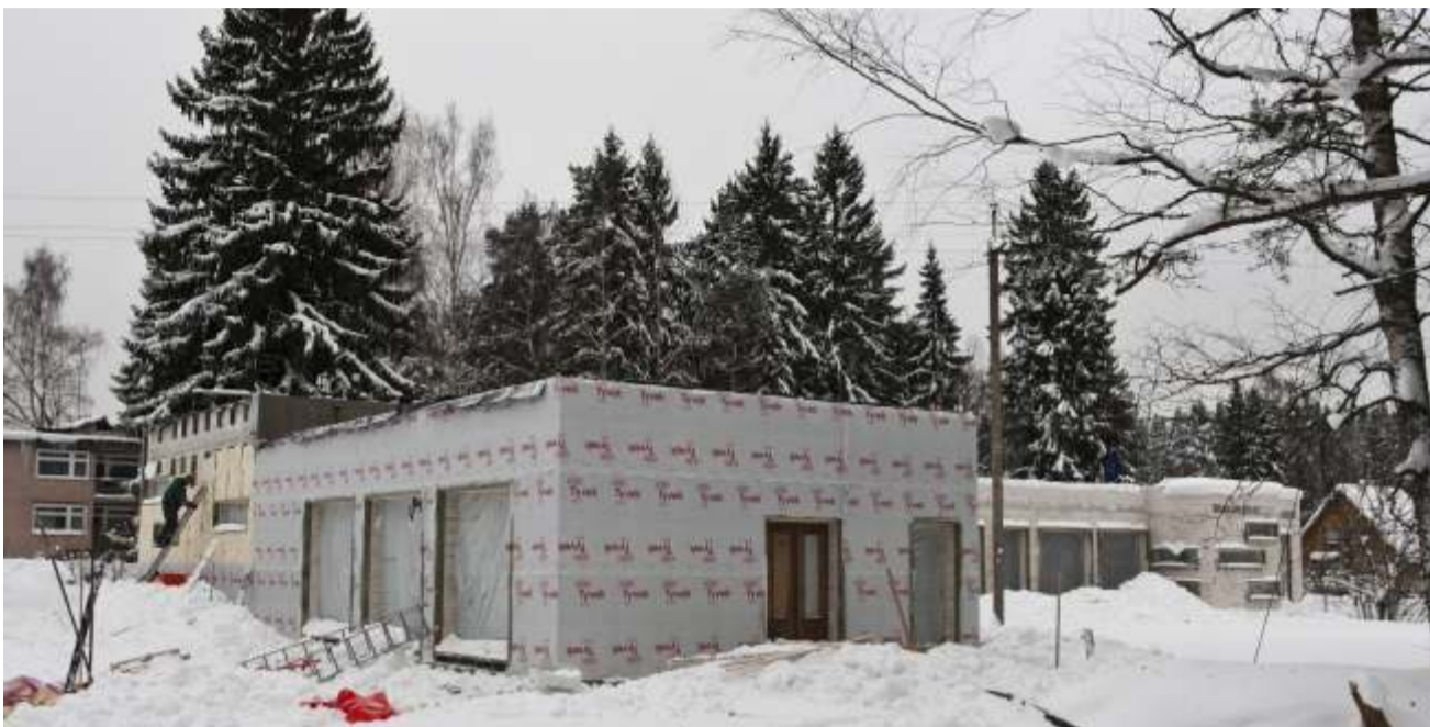
Võsupere lasteaed-raamatukogu-küla keskuse hoone ehitustöödega ollakse graafikust ee.
