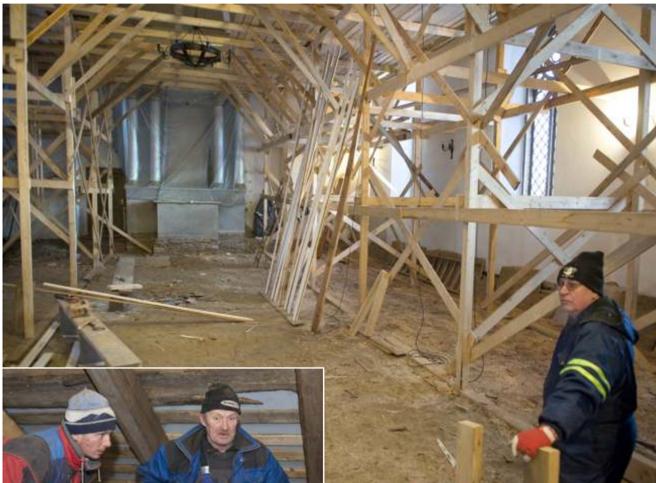
Talgute käigus veeti kirikust välja eelneva ehituse käigus tekkinud praht, toestati tellingud, keskmine osa kiriku saalist vabastati tellingutest. Ehitust kirikus koordineerib Mati Piirsalu.
